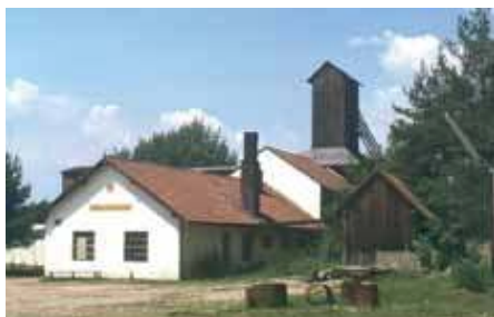
16 Marienschacht bei Wölsendorf vor dem Abriss Foto: H. Wolf
